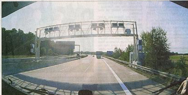
Ein Eckpfeiler des Mautsystems: Mit den Autobahn-Kontrollbrücken soll eine kilometergenaue Abrechnung möglich sein.
